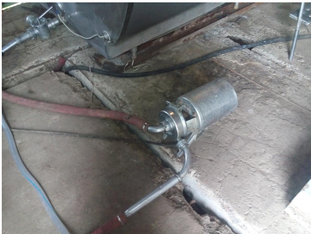
Рисунок 4.22 - Подача воды из льдохранилища в систему охлаждения молока в молочном отделении
