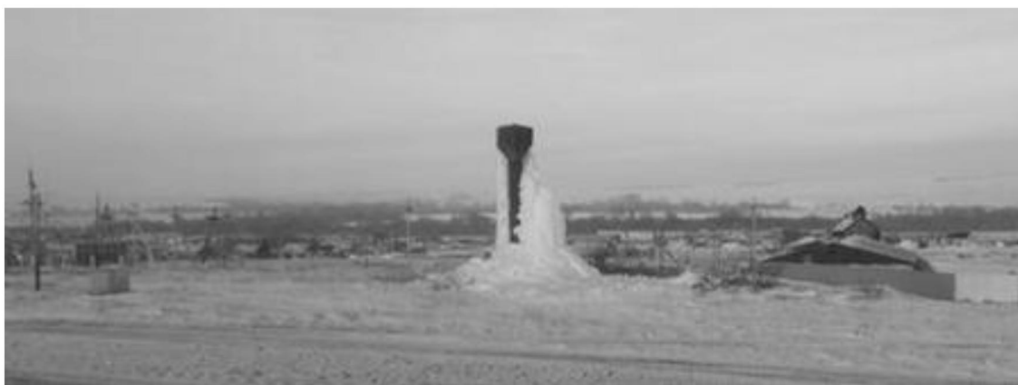
Рисунок 1.2 – Конфигурация внешнего обледенения водонапорных башен
